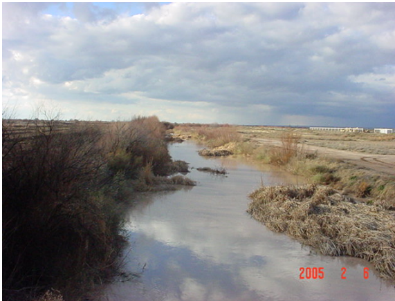
Figura 1, Dren de E.U. en el flujo del río
